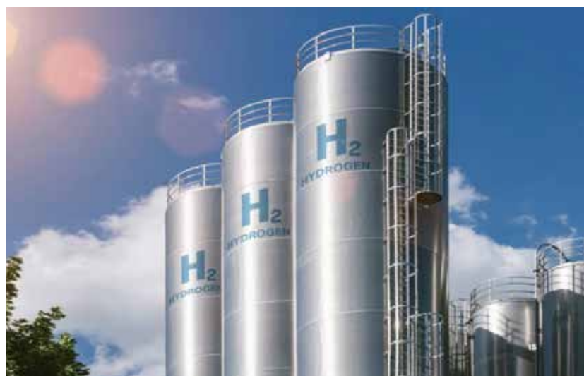
圖一、綠氫 (Green hydrogen) 是由可再生能源所提供電能來進行電解水所產製的氫氣，是對環境最友善的產氫方式。(作者提供)
