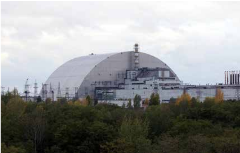
圖七、歐洲復興與開發銀行在 2015 年為車諾比核電廠 4 號機組反應堆大樓建造了第二層巨大的石棺，工程耗資 23 億美元。
