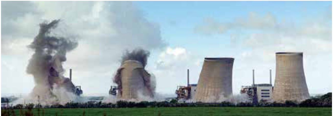
圖二、位於英國北部蘇格蘭的Chapelcross 核電廠於 2007 年退役，冷卻塔被炸毀後拆除。
