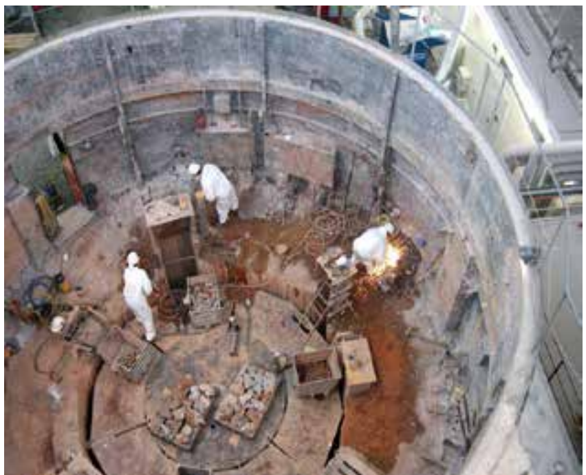
圖三、核電廠設備拆卸時，至關重要的是放射性污染物或化學污染物應包含在密封的環境中，並且不得釋放到空氣或地下水中，以免輻射或化學物質隨風或地下水遷移到附近人和動物及土地上，造成污染。
