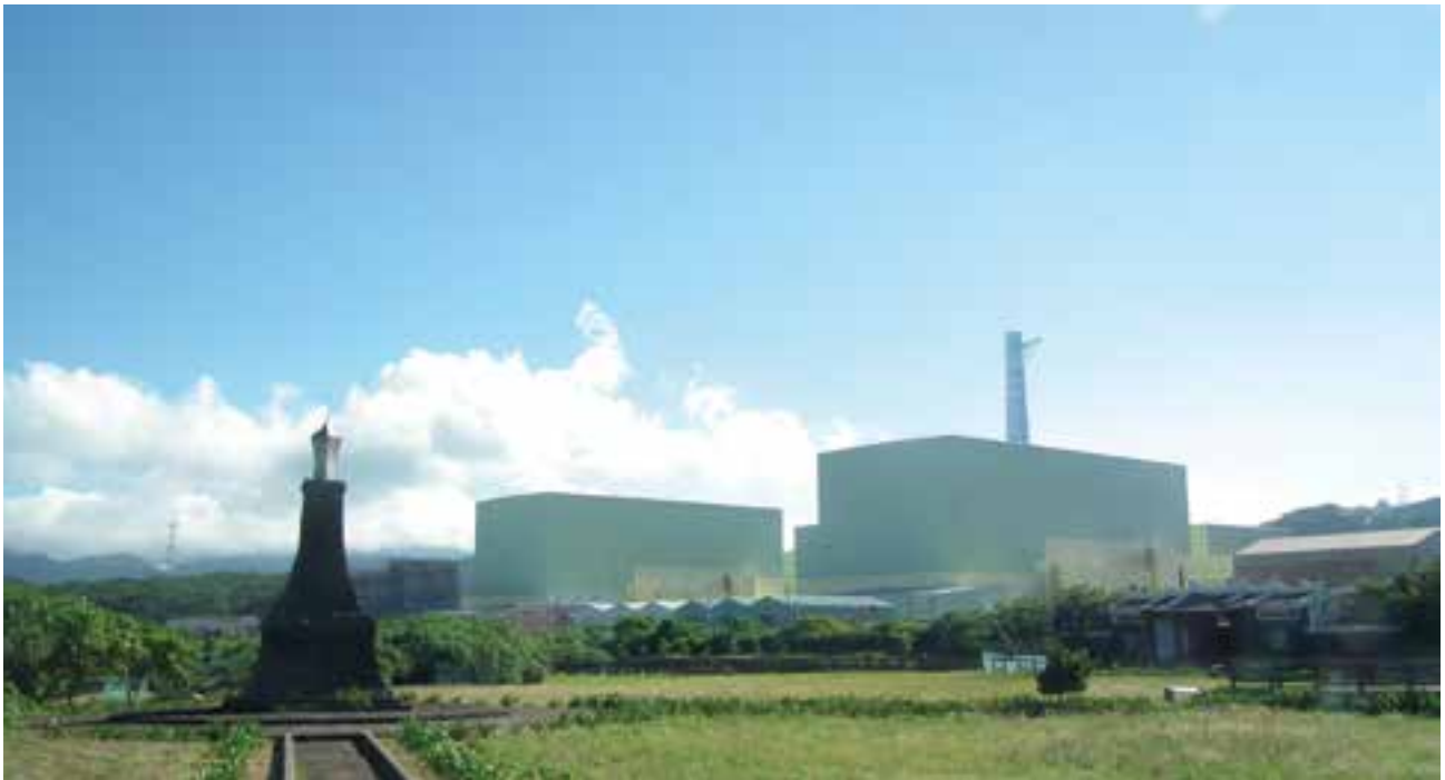
遠處圍阻體左起分別為核能第四發電廠一號機、二號機；左方為鹽寮抗日紀念碑。（圖片提供：Toach japan）
