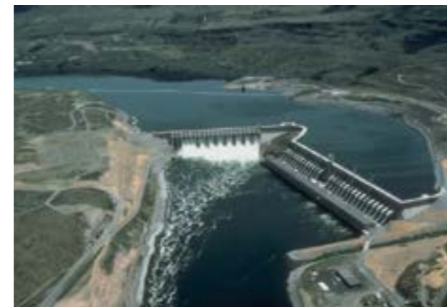
圖一、美國聖母大學小水力發電既有壩壩
