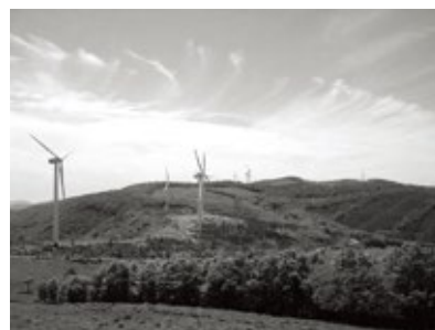
上外川高原高山風力發電廠
