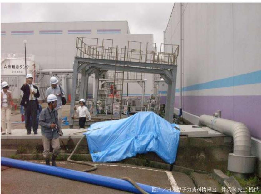
則是指震源正上方的地面位置)。地震造成柏崎、刈羽核電廠所在的海岸線下沉120公分，廠房腹地中央部位卻隆起10公分。廠房內到處地層下陷，並出現道路起伏呈波浪狀，上下有段差。事發當時柏崎、刈羽核電廠的7座機組中，1、5、6號等3座機組因剛好年度定期檢查，沒有運轉。運轉中的4座機組（3、4、7號及啟動試驗中的2號），因偵測到強震的搖晃而自動停機，才避免造成更慘重的災情，可謂不幸中的大幸。
