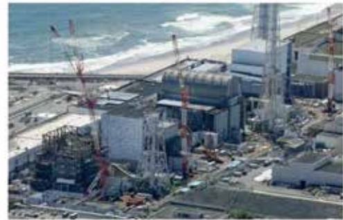
圖二、日本石川縣的能登半島在 2024 年元旦發生規模 7.6 強震，臨近的志賀核電一開始宣布沒異樣，其後承認變壓器管線爆炸而漏油，漏出油量是公布的 5 倍，到 1 月 10 日又再度承認曾遭 3 公尺高海嘯侵襲。一再說謊讓日本民眾非常擔心。
