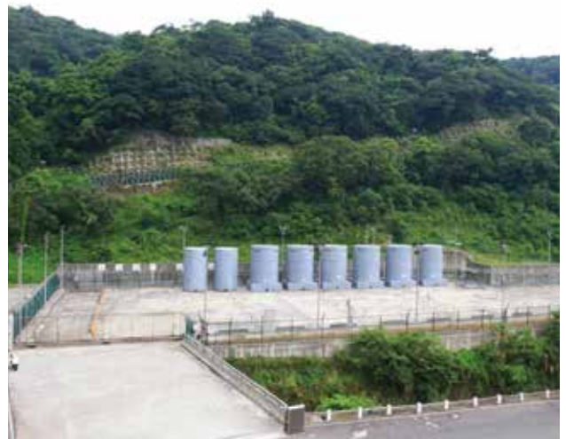
圖一、核一廠－室外乾式貯存場圖。 （圖片來源／作者提供）
