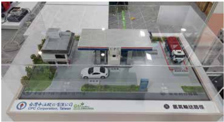
圖一、中油示範站主要設施可分為三區（氫氣供應區、可移動式加氫站設備主體區、加氫泵島區）。（圖片來源／中油網站）
