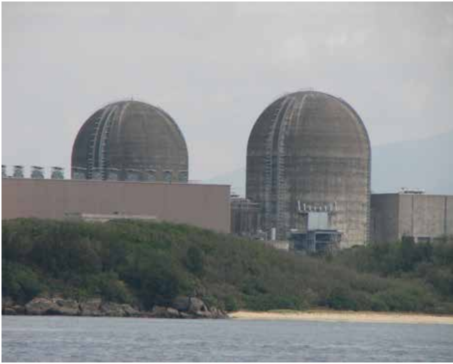
圖一、核三廠外觀明顯與核一與核二廠不同，有兩座高聳的鋼筋水泥圍阻體，因為核三廠是壓水式反應爐，反應爐與蒸汽產生器都在 150 大氣壓的環境下運轉，兩項設備都需要鋼筋水泥圍阻體保護。
